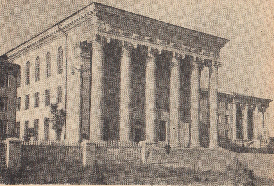
Здание Киргизского сельскохозяйственного института (архитектор И. Гомелина).
