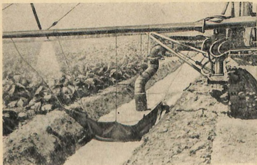
Рис. 5. Брезентовая перемычка трапецидального сечения (вид с нижнего бьефа)
