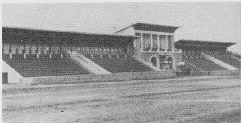
Трибуны ипподрома. Восточный фасад. 1953 год.
